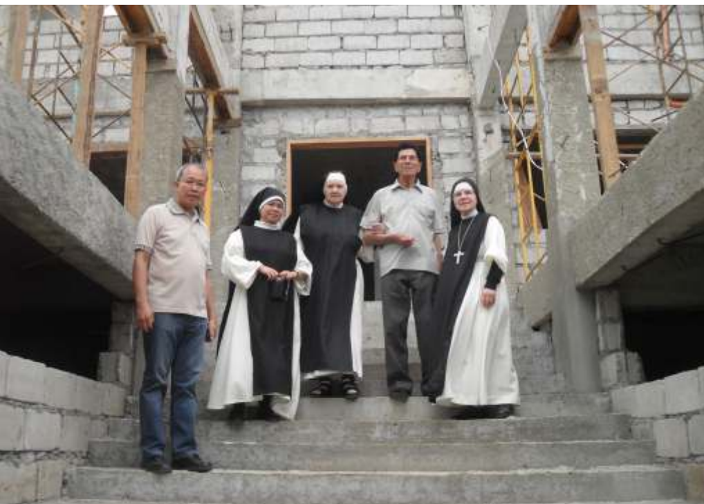
Il cantiere del nuovo monastero.
