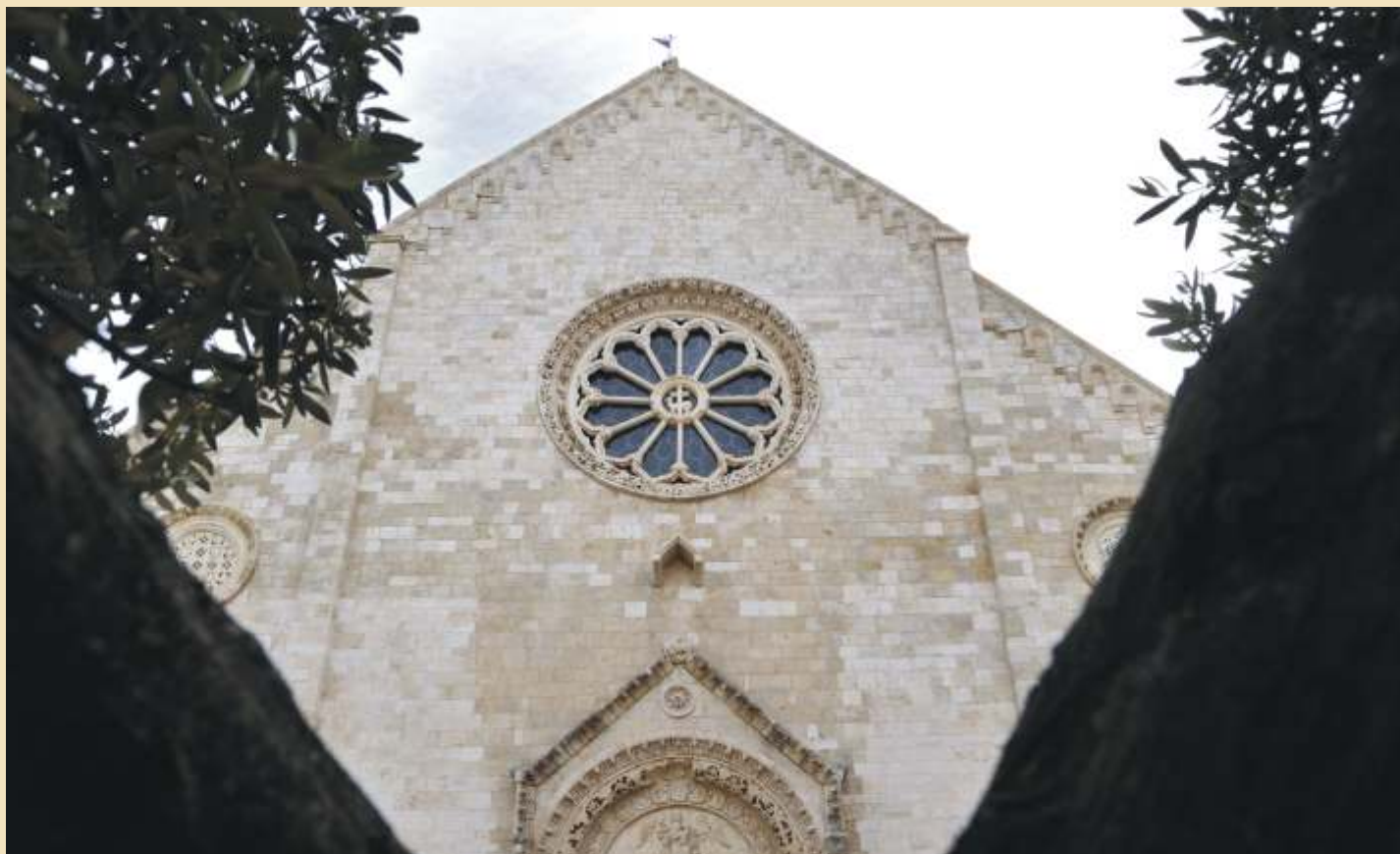
Facciata della Basilica Cattedrale di Conversano dopo i lavori di restauro.
